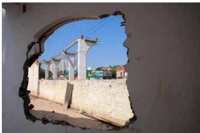
In der Águas Espraiadas in São Paulo wurden die Häuser eines Armenviertels abgerissen und die Bewohner enteignet.
